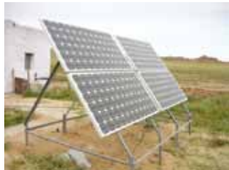
強風対策を行った設置方法
